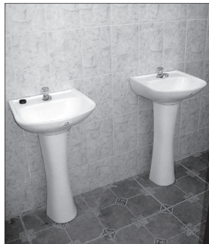
Antes de materializarse esta obra, los clientes debían utilizar los baños que se encuentran en las oficinas del sindicato.
